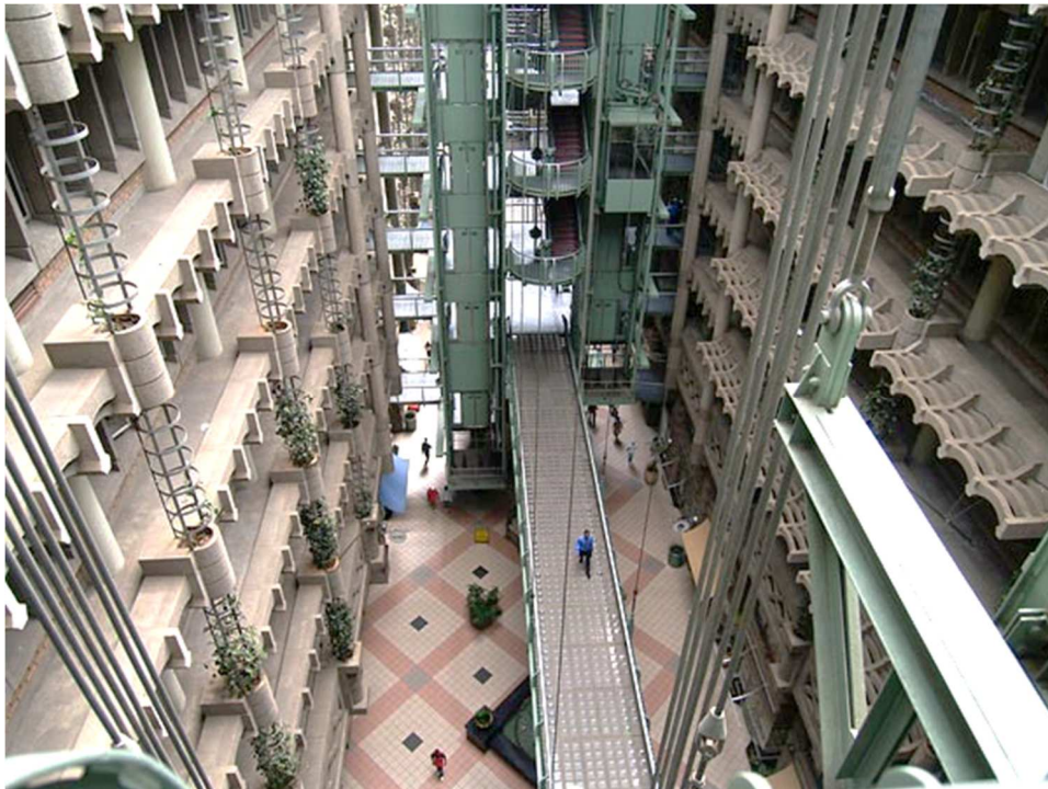
Interior do Edifício - permeabilidade estrutural
