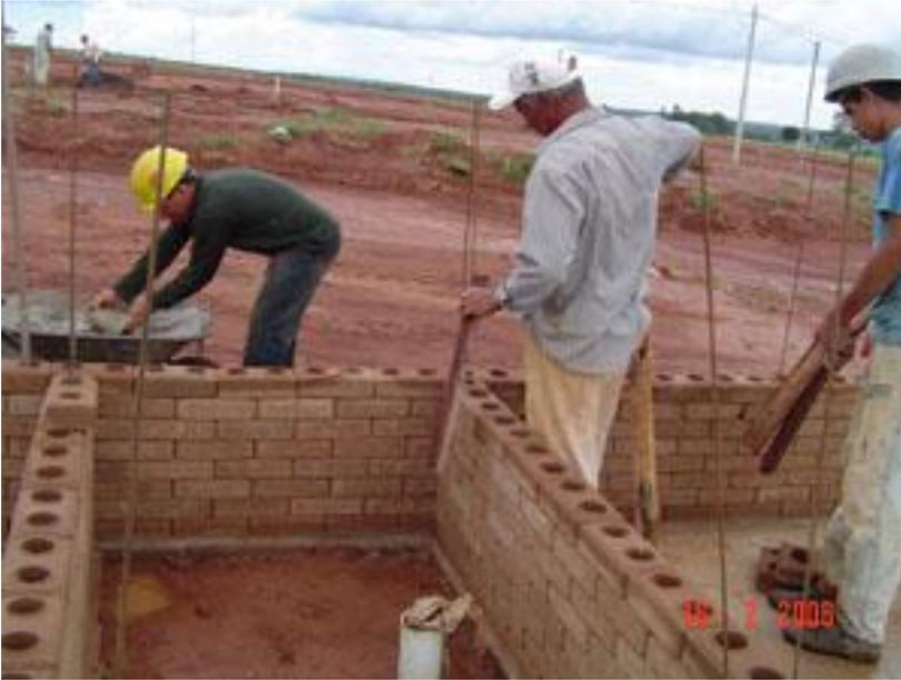
**Figura 40:** Construção com Tijolos Encaixáveis - Ação Moradia.
