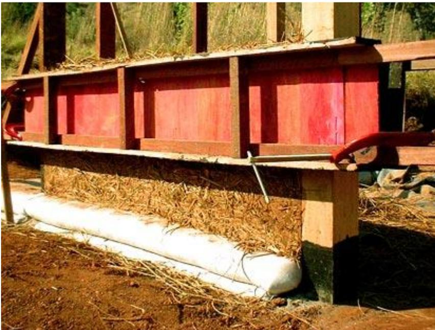
**Figura 26:** Taipa Leve, técnica utiliza basicamente palha de arroz.
