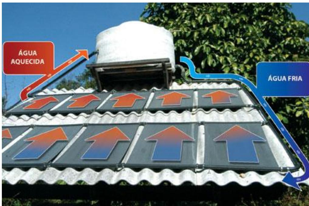
**Figura 28:** Aquecedor Solar de Baixo Custo usado para aquecer a água usada no IPEC.
