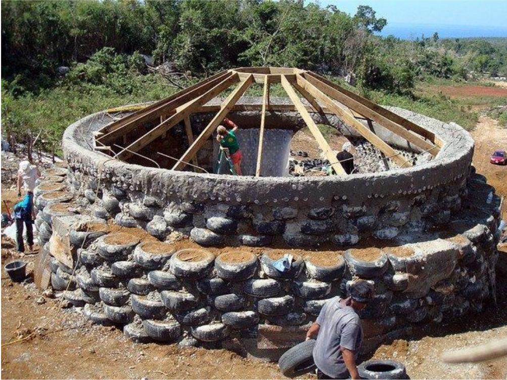
**Figura 27:** Chalé em círculo sendo construído com Pneus Velhos.
