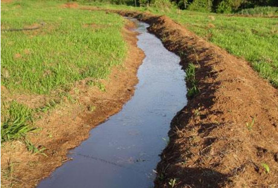
**Figura 14:** Vala de infiltração ou “*swale*” no Ecocentro IPEC.
