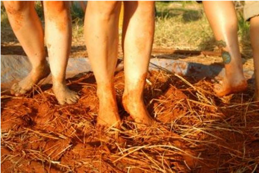
**Figura 25:** Preparação do Cob, feito com argila e palha de arroz.
