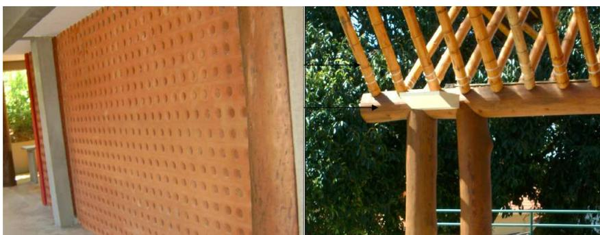
**Figura 14 - Parede de Tijolo solo cimento e Estrutura em bambu e eucalipto do telhado**
