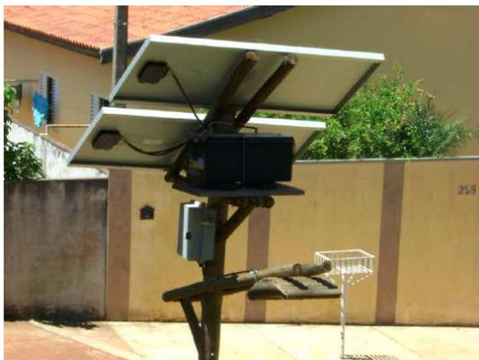
**Figura 16 - Sistema de iluminação de células fotovoltaicas e LED**
