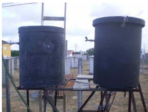
Figura 3.5. Reservatórios térmicos RT 150 e RT 200 do sistema de aquecimento solar estudado.
