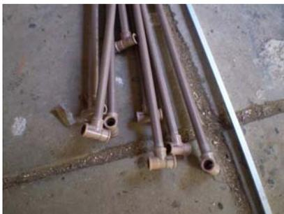
Figura 3.1. União entre tubos e conexões de PVC.
