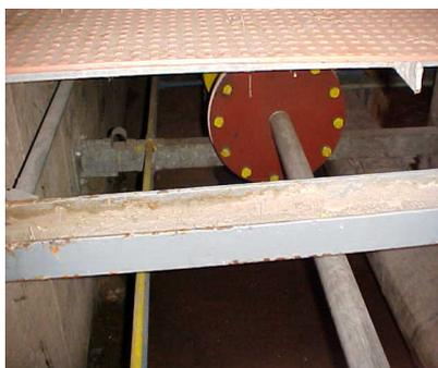
**Figura 6.10 – Tubulação de alimentação da Caldeira e da instalação da Microturbina**
