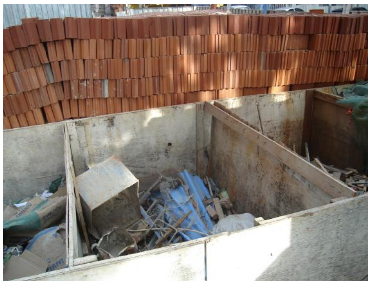
Figura 4: Vista superior da baía, contendo restos de resíduos de construção civil (Maio de 2008).
