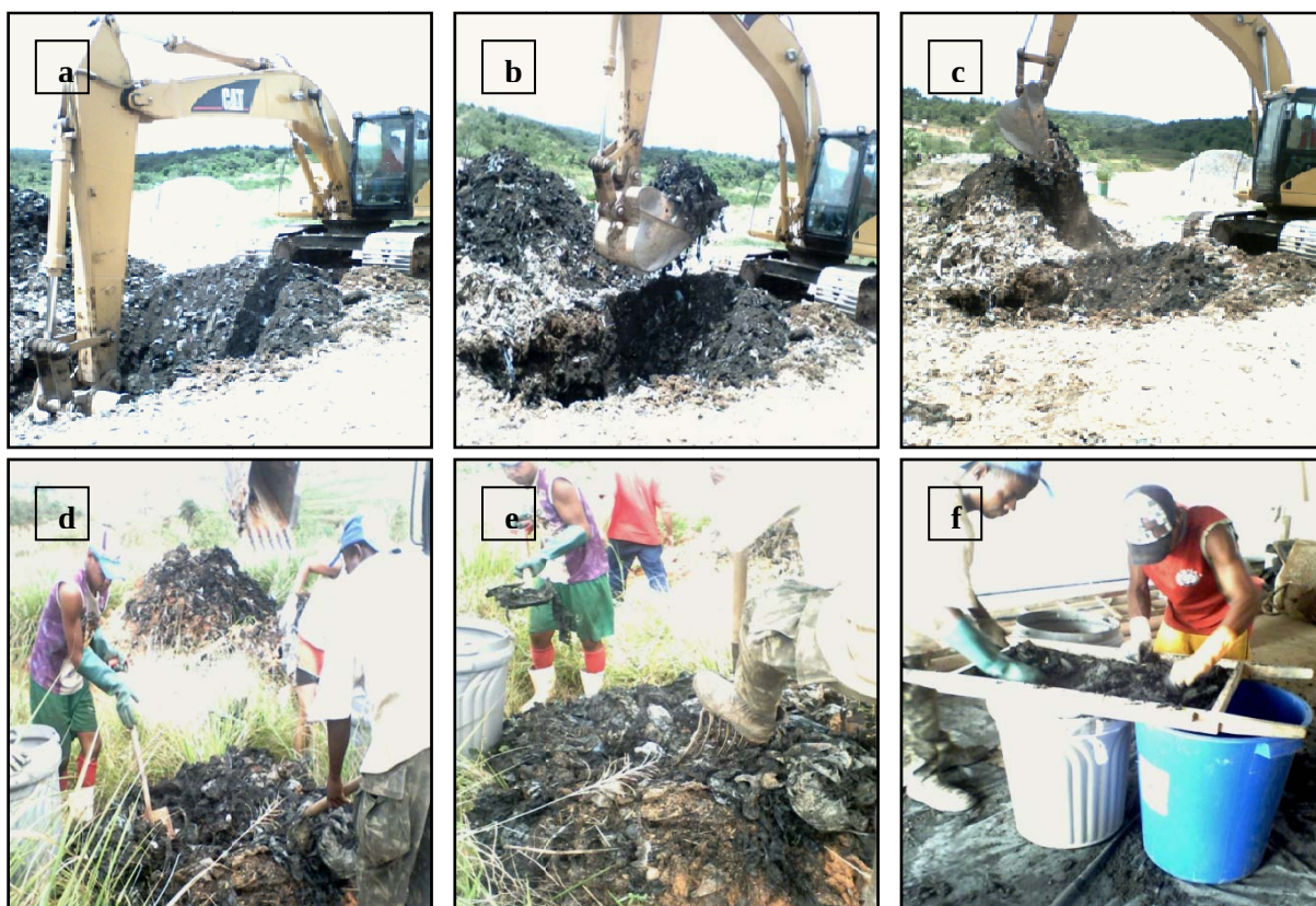
Figura 3.6. Coleta da amostra de resíduos com 7 anos: (a), (b) e (c) Escavação da célula de lixo desativada; (d), (e) e (f) Retirada e separação da amostra.
