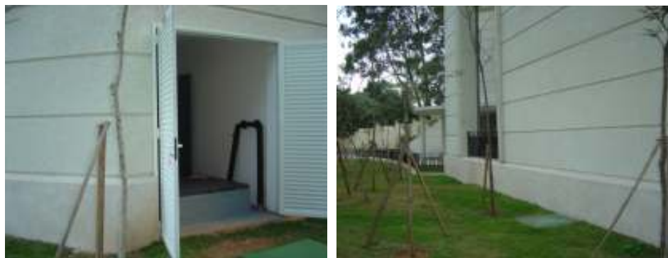
Figura 5.10: Espaço físico destinado a ETE para água de reúso.
