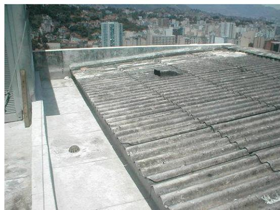
Figuras 5.5 e 5.6: Um terraço destinado ao uso social e um exemplo de telhado de fibrocimento construído sobre laje. Fonte: Arquivo pessoal do autor.
