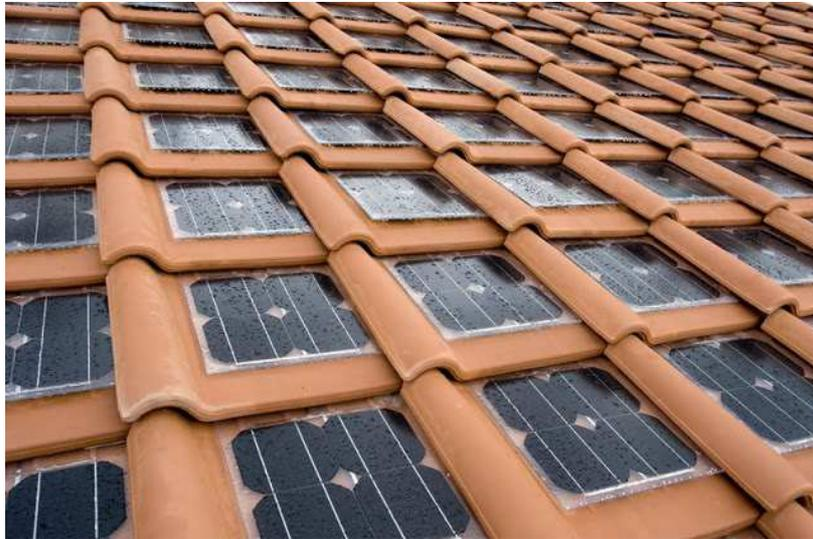
Empresas italianas Area Industrie Ceramiche e REM uniram suas tecnologias, criando a Tegola Solare, construída p/ converter a luz solar em energia e manter a estética e a harmonia do telhado.
