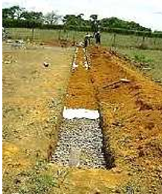
Vala em construção
