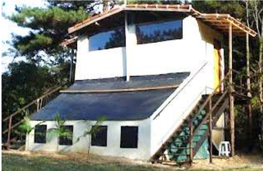
Sanitário com 4 câmaras de compostagem
