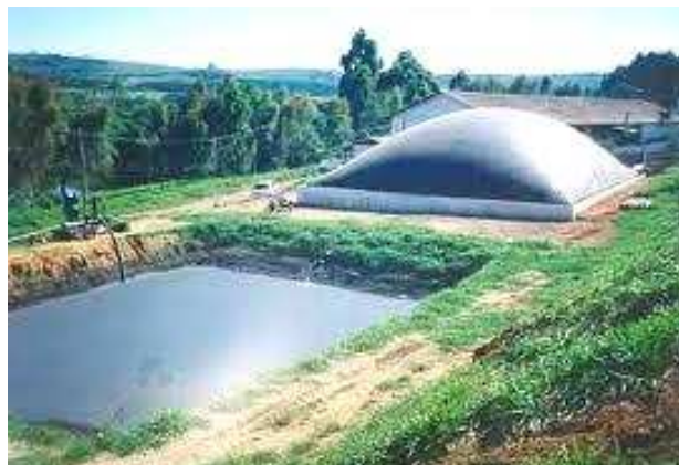
Biodigestor com cúpula móvel
