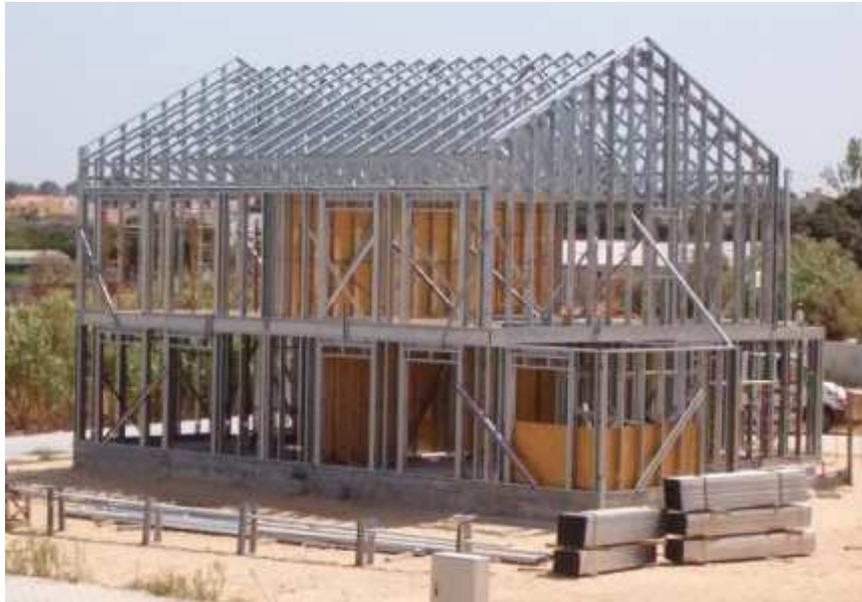
Estrutura metálica em residência: não recomendável, mesmo c/ a vantagem da pré-fabricação
