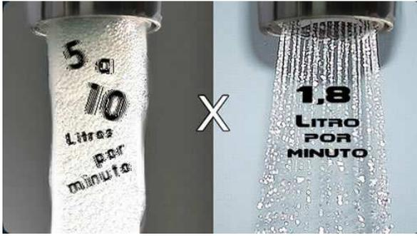
Torneira sem e com redutor vazão
