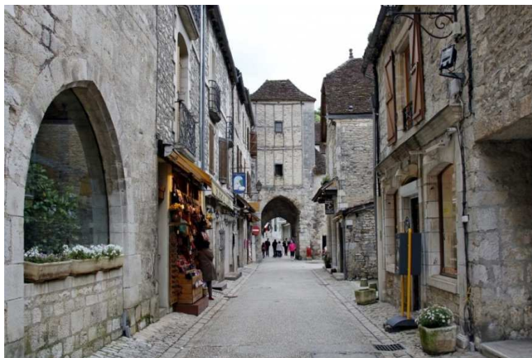
Ruas estreitas – má ventilação e iluminação nas edificações
