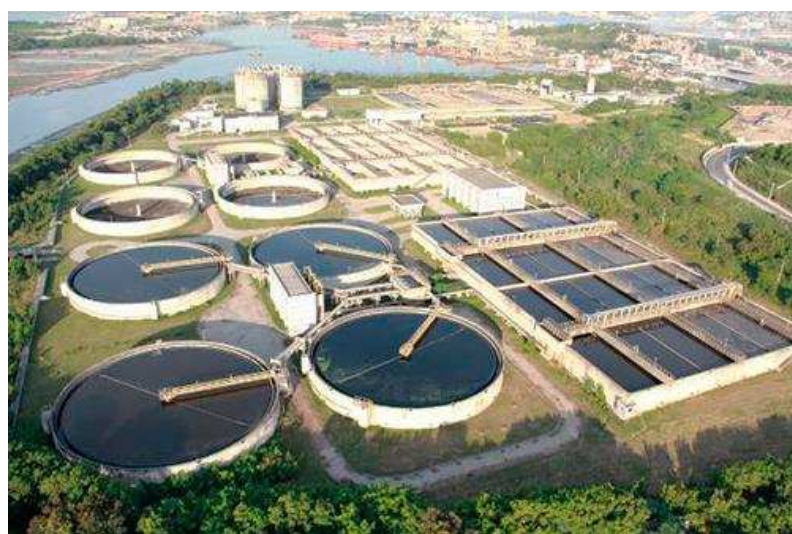
Estação de Tratamento de Esgoto - Rio de Janeiro/RJ
